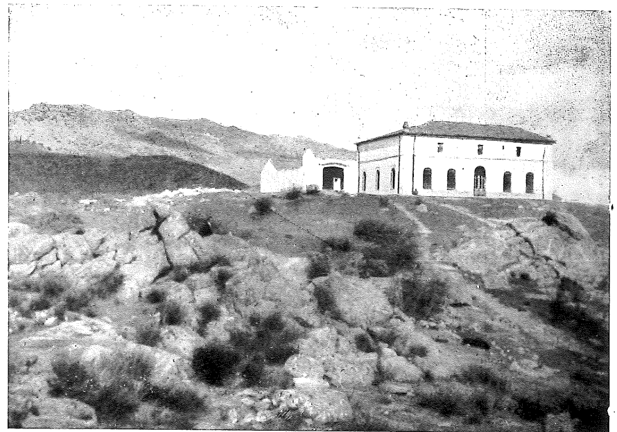
Fig. 2.— Detalle de una casa típica de labor en la dehesa de Alijares. Al fondo la zona alta de la sierra granítica, dominada por el vértice Alijares, cubierta de retamares y resto de arbolado de encinas.
